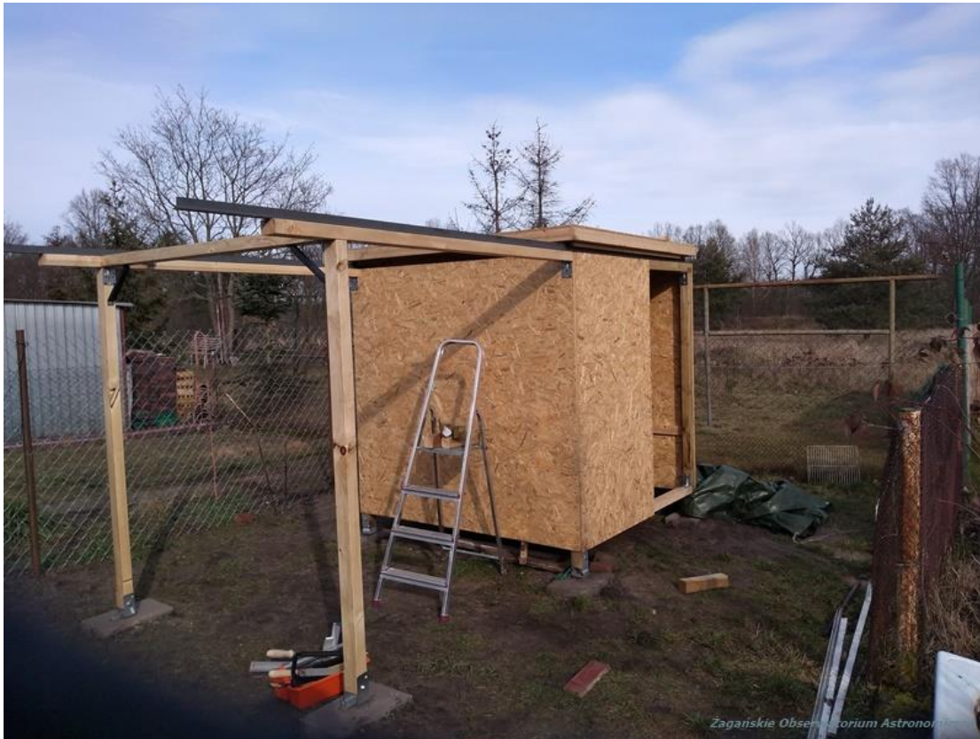
Fotografia 5 Strop na szynach to podstawa otwieranego dachu
