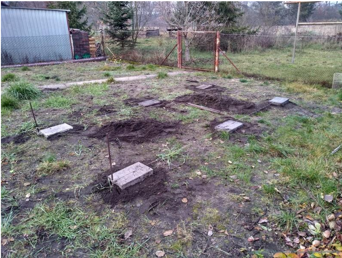
Fotografia 2 Na początku był .... fundament na ściernisku
